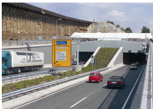
Source: Herrentunnel Lübeck GmbH & Co. KG
