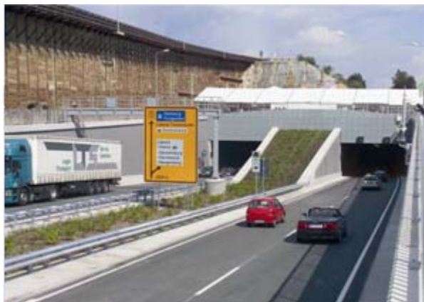
Quelle: Herrentunnel Lübeck GmbH & Co. KG
